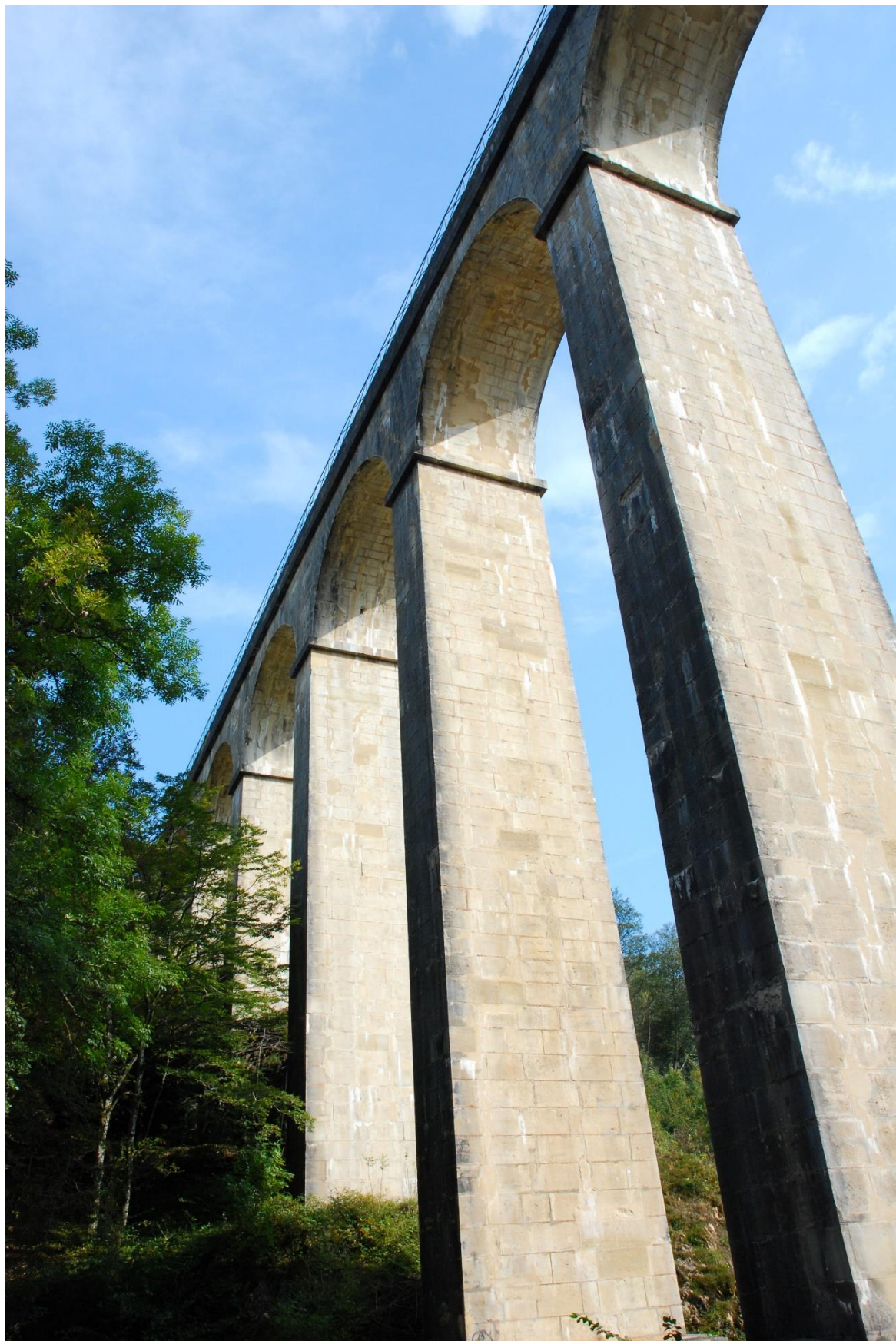
L'aqueduc de Montreuillon à la rencontre du ciel
